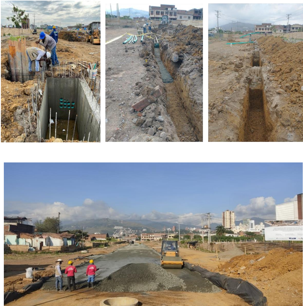
Figura 20 - Fotos de avance en la Carrera 12
