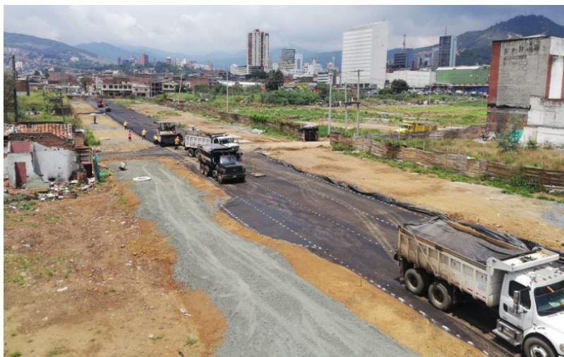
Figura 17 - Avances en el proyecto de canalización de la Carrera 12
