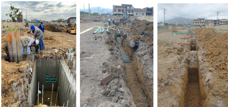
Figura 22 – Fotos de avance en la Carrera 12
