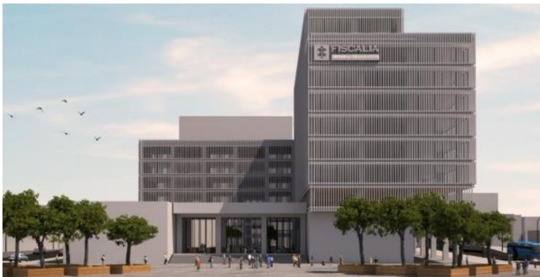
Figura 6 – Imagen del Bunker de la Fiscalía
