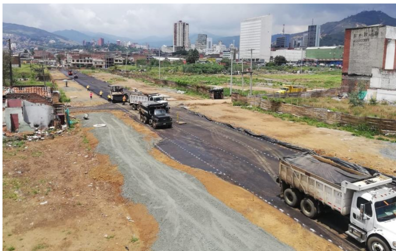
Figura 16 - Avances en el proyecto de canalización de la Carrera 12
