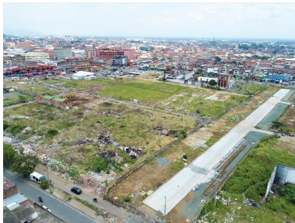
Figura No.76 Obras de Urbanismo en Ciudad Paraíso
