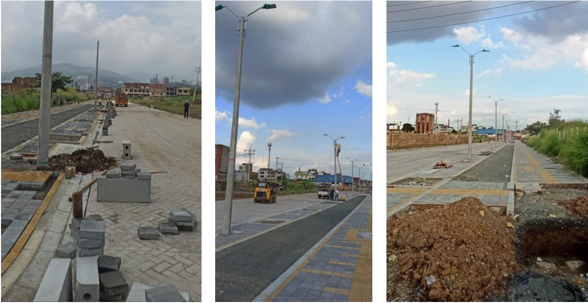
Figura No. 12 - Avances en el proyecto de canalización de la Carrera 12
