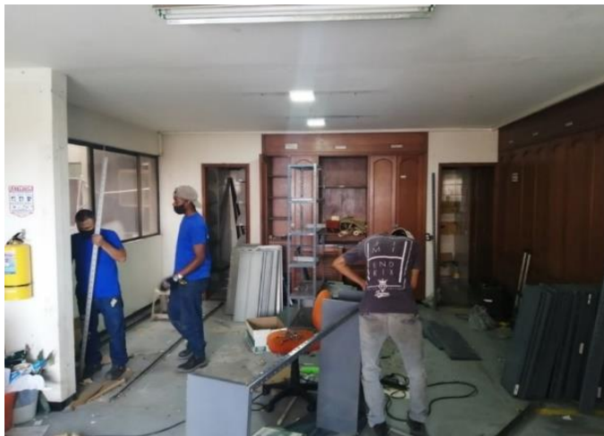
Fuente: Informe gestión administrativa, Arquitecto Iván Torres
