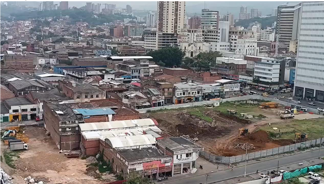
Figura 13 Avance de obra del Bunker de la Fiscalía General de la Nación.
