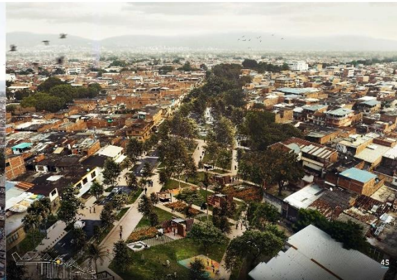
ACCESO CIUDAD DE CALI IMAGEN AEREA
