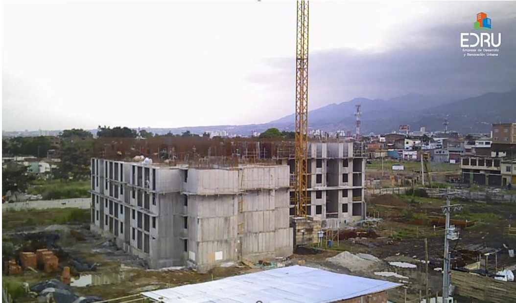
Figura 21 Fotos de construcción del proyecto
