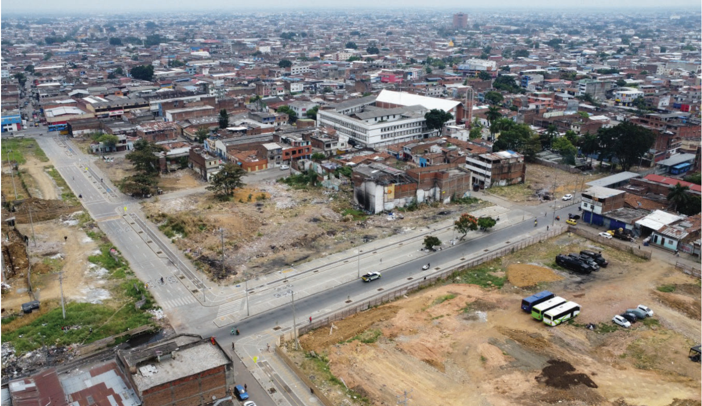
Figura 106: Fotos, Biblioteca digital Empresa de Desarrollo y Renovación Urbana EDRU / Ampliación Vial carrera 12 y calle 13 / Presentación Cali ciudad sostenible 2023
