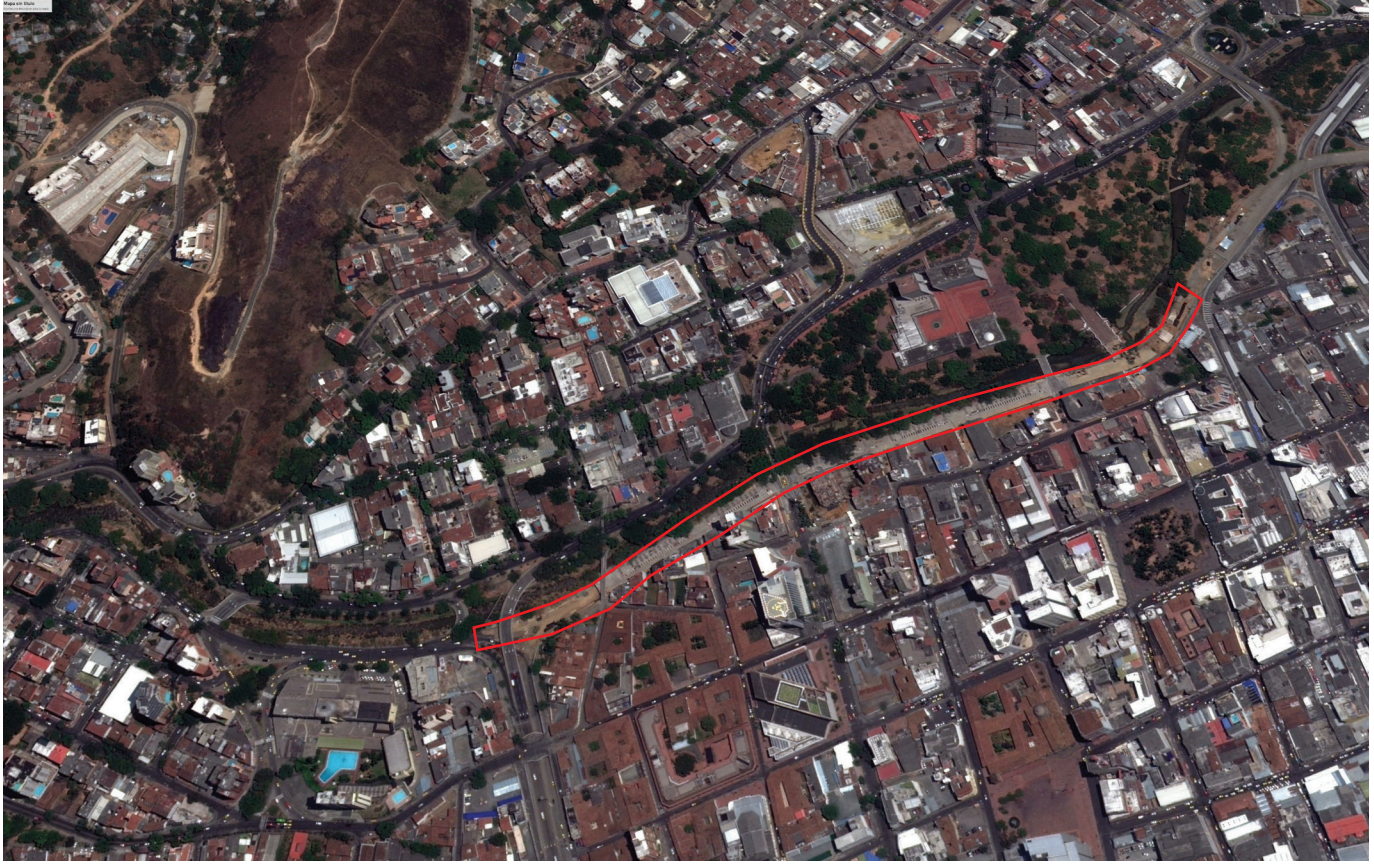
Figura 56: Foto satelite, Google Earth / Ubicación Hundimiento de la Avenida Colombia
