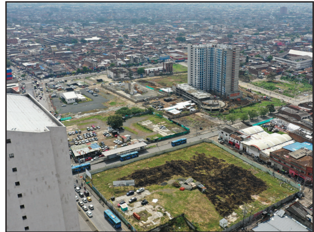
Construcción de torre 1 de ciudad paraíso, inicio de obra de búnker de la Fiscalía
