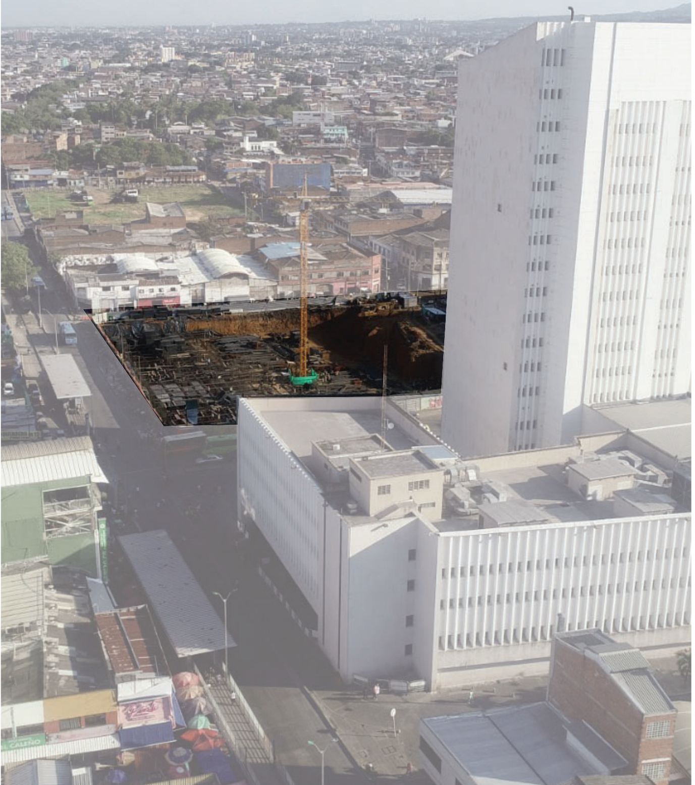
Figura 86: Foto, Biblioteca digital Empresa de Desarrollo y Renovación Urbana EDUR / Avance d obra nov 2023
