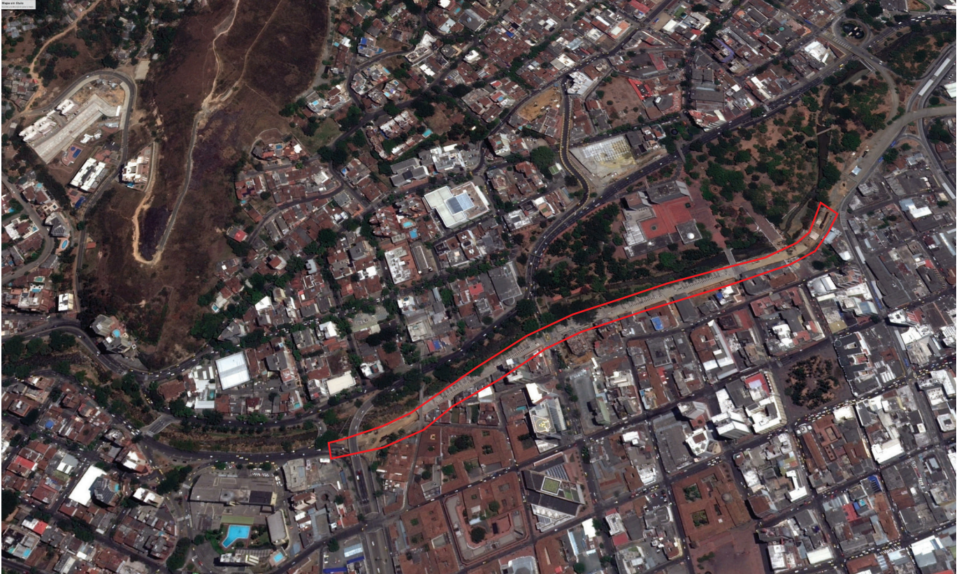
Figura 60: Foto satelital, Google Earth/ Ubicación de Bulevar del Río
