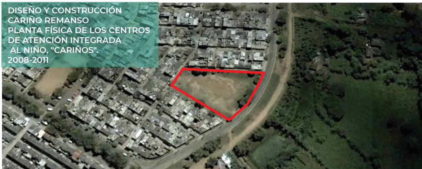
Figura 28: Foto satelital, Google earth/ ubicacion Centro de Atención Integrada Cariños Remanso
