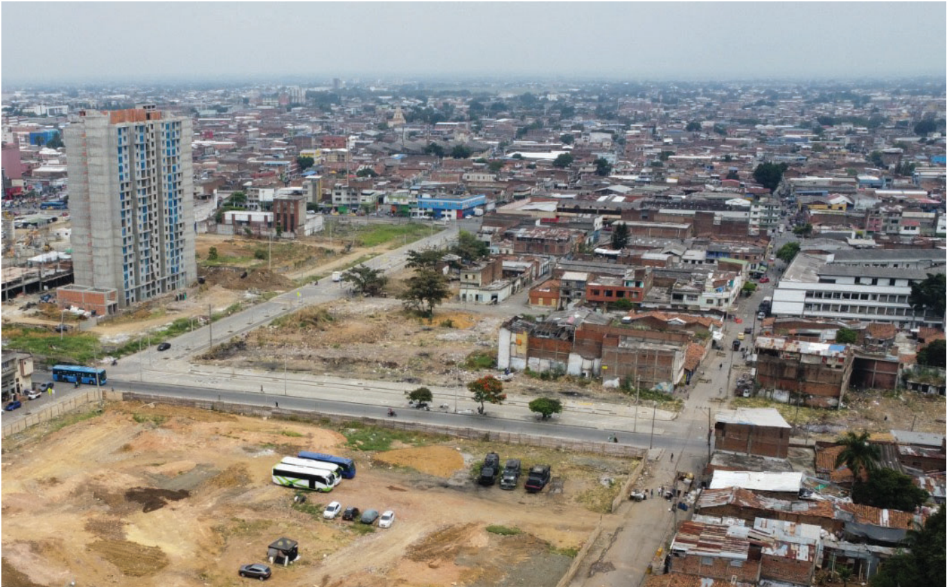
Figura 107: Fotos, Biblioteca digital Empresa de Desarrollo y Renovación Urbana EDRU / Ampliación Vial carrera 12 y calle 13 / Presentación Cali ciudad sostenible 2023
