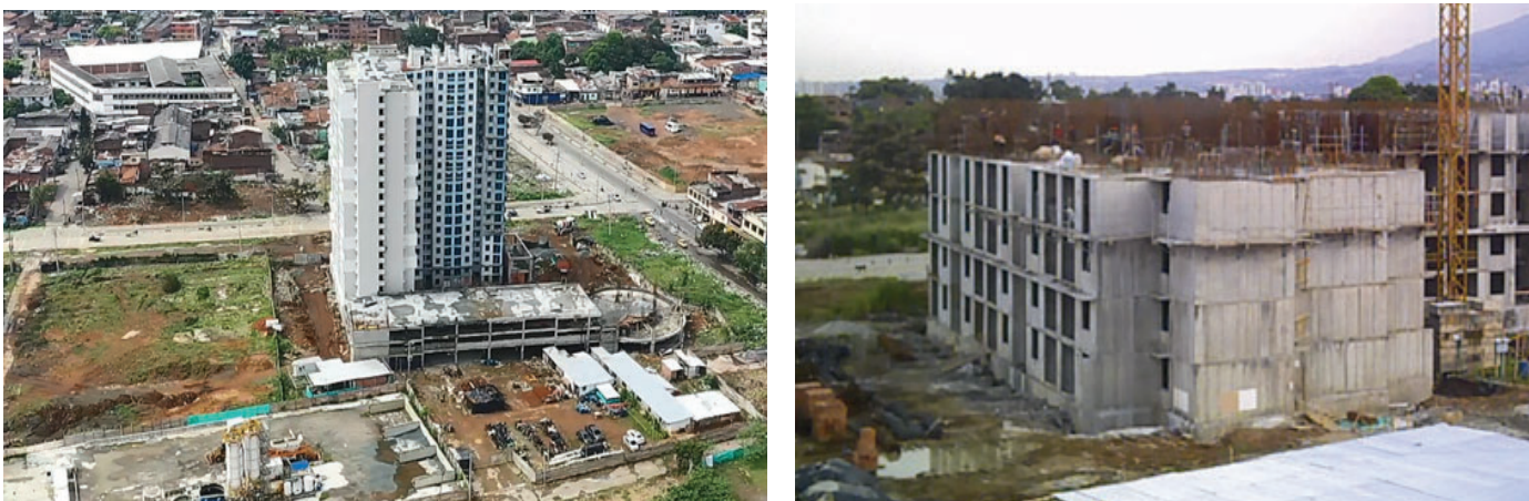
Figura 89: Foto, Biblioteca digital Empresa de Desarrollo y Renovación Urbana EDRU/ Proceso de construcción de torre 1 Ciudad Paraiso
